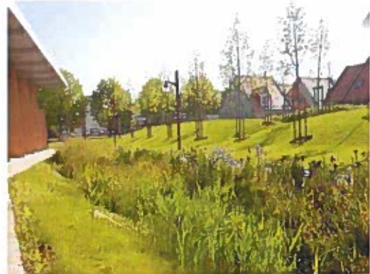
Figure 2 : Exemple de noue d'infiltration n°2
