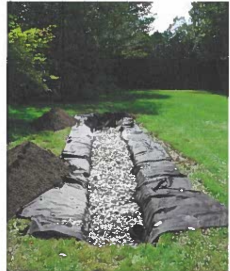
Figure 1 : Exemple de tranchée d'infiltration
