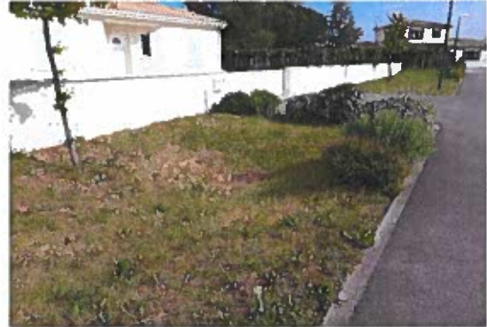
Figure 1 : Exemple de noue d'infiltration n°1
